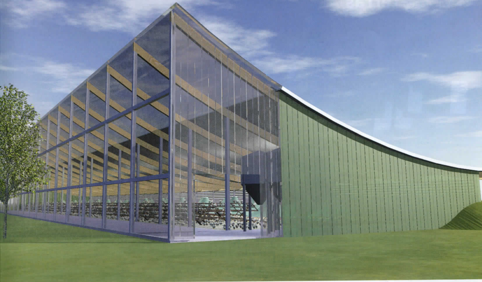
De speciale vorm van het dak van de Windstreekstal zorgt voor optimale luchtcirculatie.
